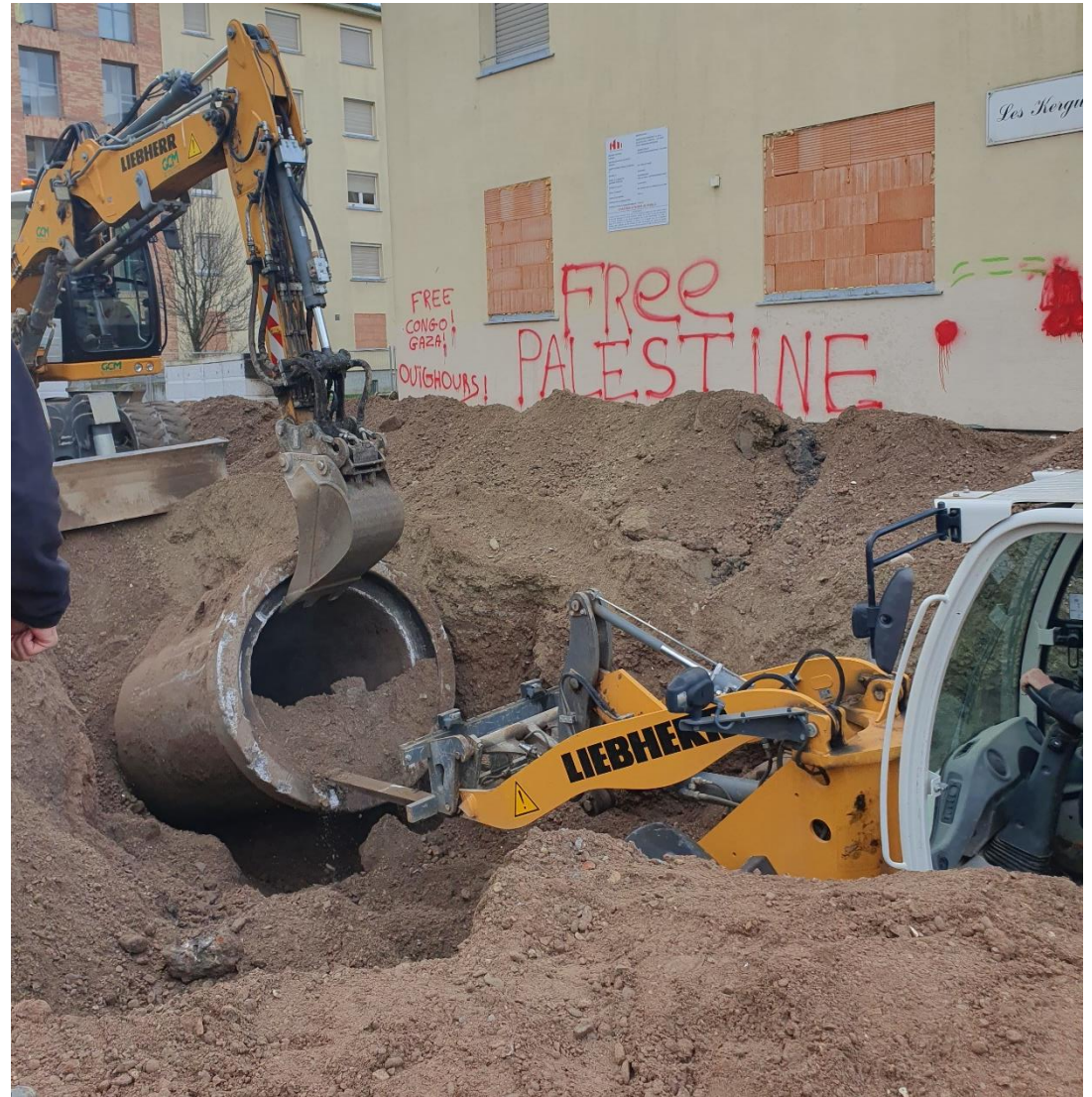
- Purge des réseaux - assainissement
