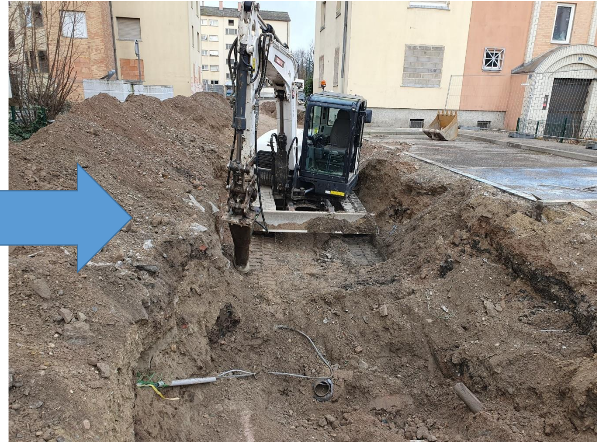
Réutilisation du concassé (250m 3 ) issu de la déconstruction Lyautey en remblai
