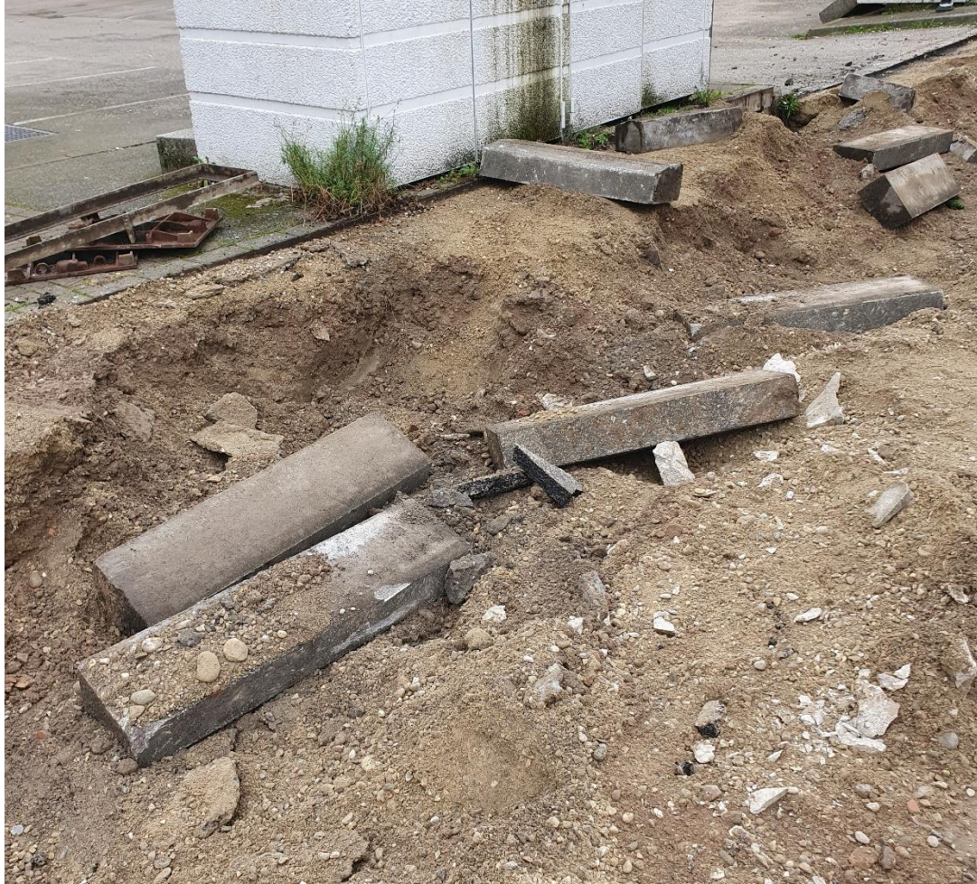
Dépose soignée bordures
