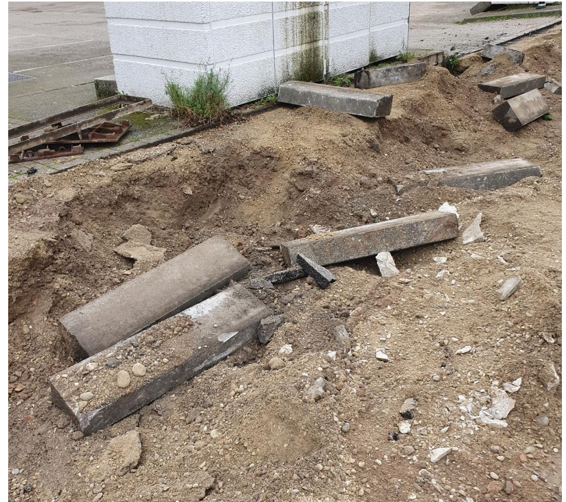
- Extraction des matériaux de réemploi - Bordure Béton T3
