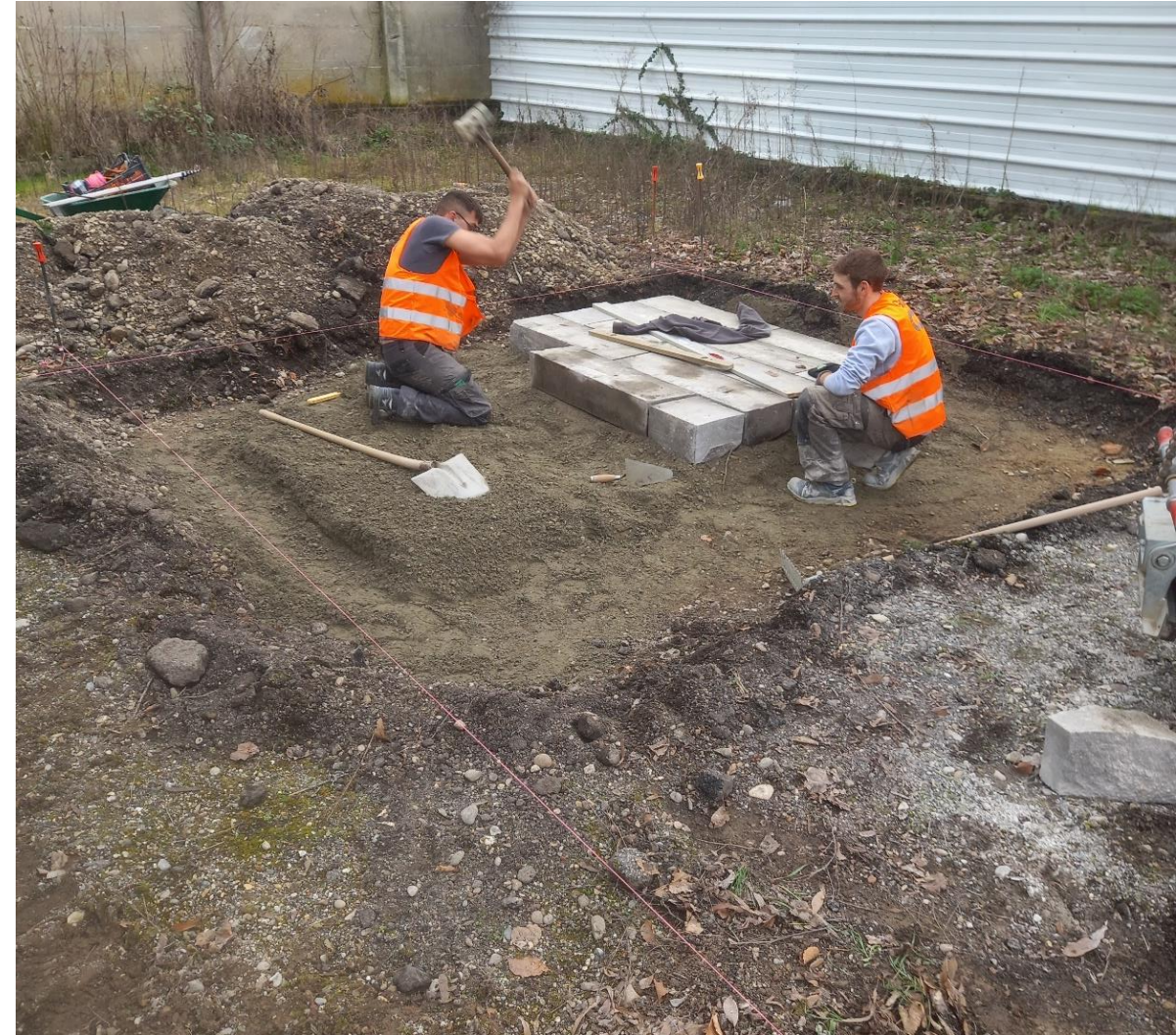
- Réalisation des planches d'essais -
