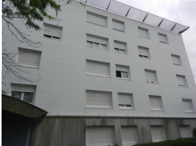
Façade Est du bâtiment 4
