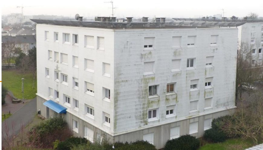
Vue sur le bâtiment 3, façades Est et Nord
