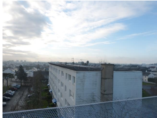
Façade Nord et Ouest du bâtiment 1
