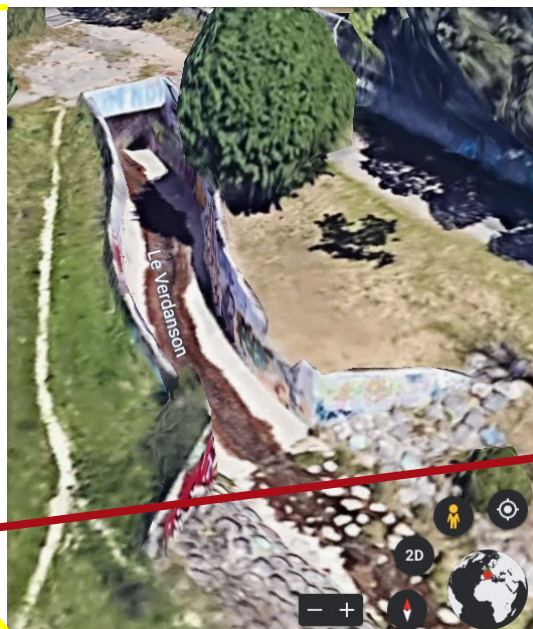
Exutoire de la partie enterrée
