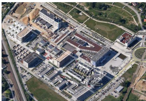
Site : Eco-quartier Bottière Chénaie
